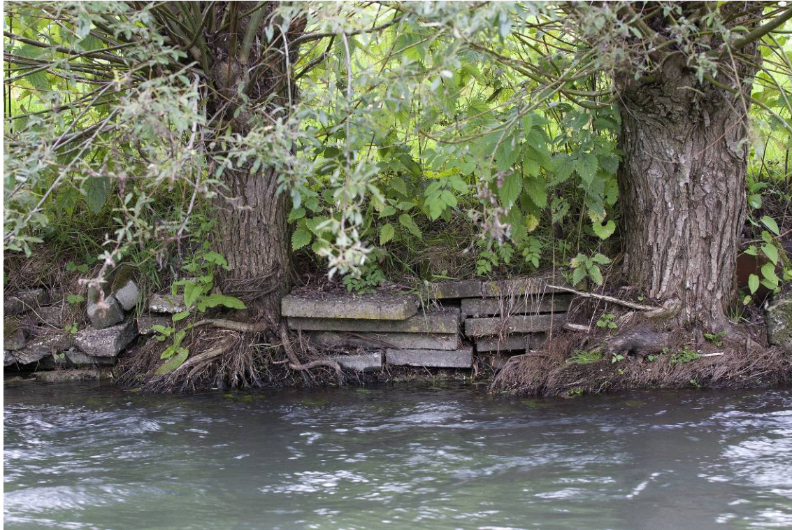
Abb. 34: Wilder Verbau an einem Gewässerabschnitt (Foto: NZO-GmbH)
