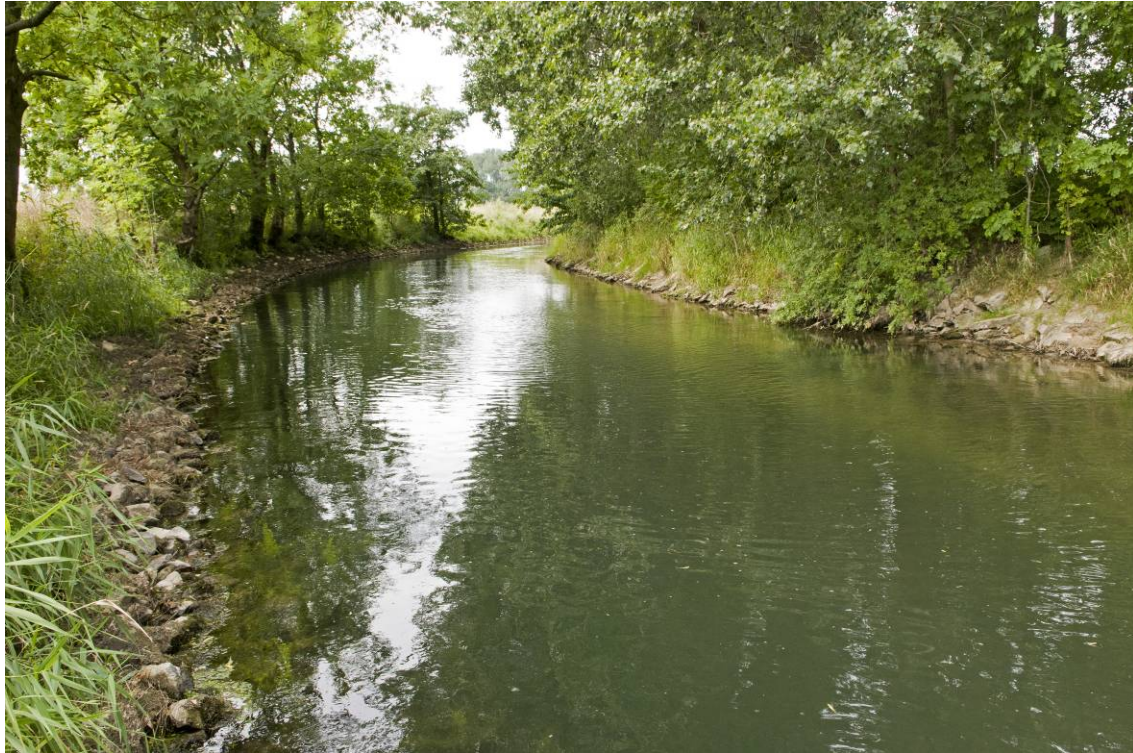
Abb. 31: Lippe unterhalb Sande – vollständig befestigt und ausgebaut (Foto: NZO-GmbH)
