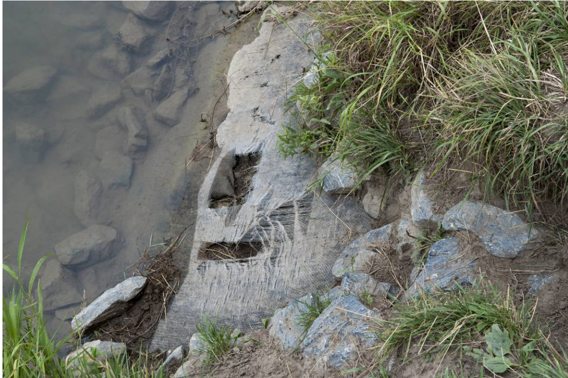
Abb. 32: Uferbefestigung an der Lippe (Foto: NZO-GmbH)
