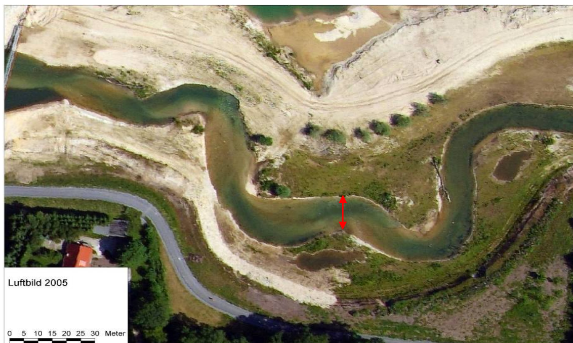
Abb. 23: Entwicklung einer intensiven Eigendynamik an der Lippeseelumflut (2005, Foto: NZO-GmbH)
