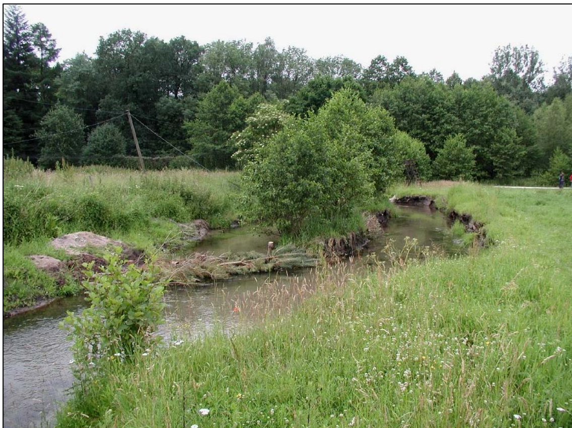
Abb. 29: Initialgestaltung durch Anlage eines Verzweigungsgerinnes am Furlbach (Foto: WOL)
